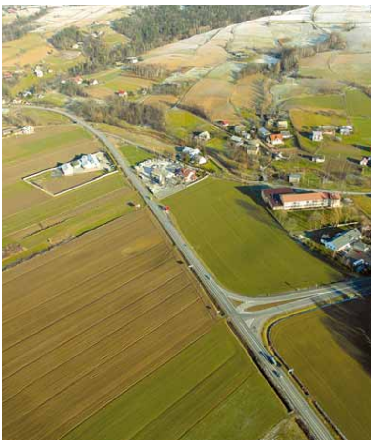
Modernizacja drogi wojewódzkiej Zaborowice krzyżówka i most w miejscowości Bobowa
