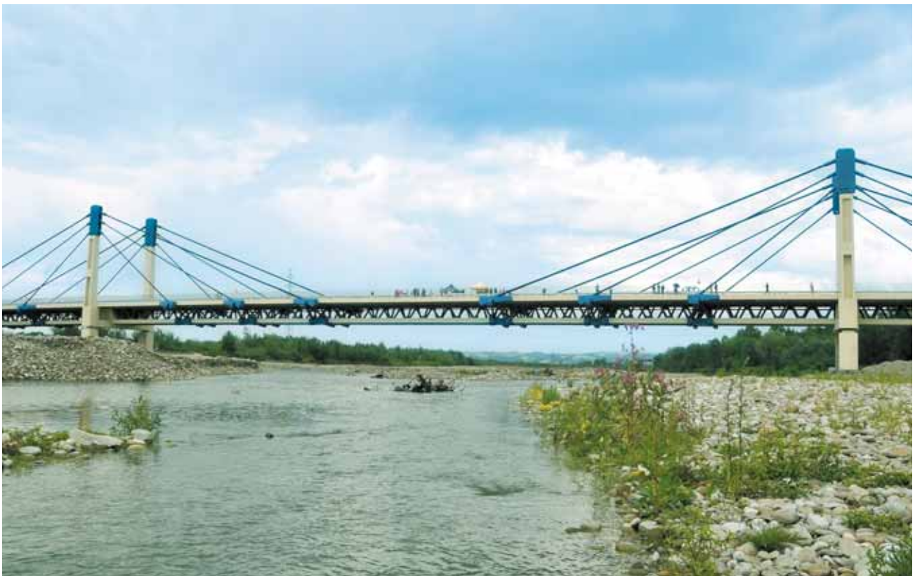
Budowa obwodnicy Starego Sącza. Most na Dunajcu
