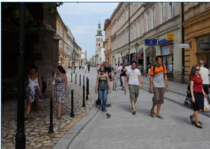
Remont nawierzchni ulicy Grodzkiej w Krakowie fot. Wiesław Majka, Urząd Miasta Krakowa
