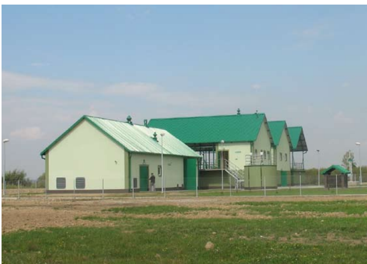
Budowa oczyszczalni ścieków i kanalizacji w Miechowicach Wielkich, gm. Wietrzychowice
