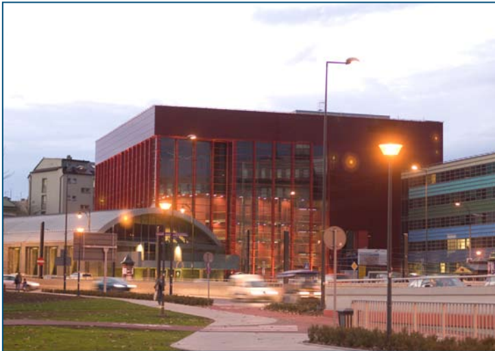
Budowa gmachu Opery Krakowskiej
