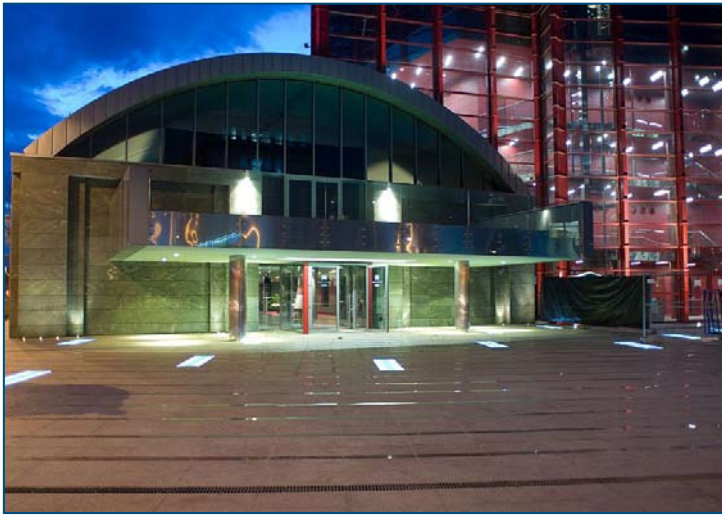
Budowa gmachu Opery Krakowskiej
