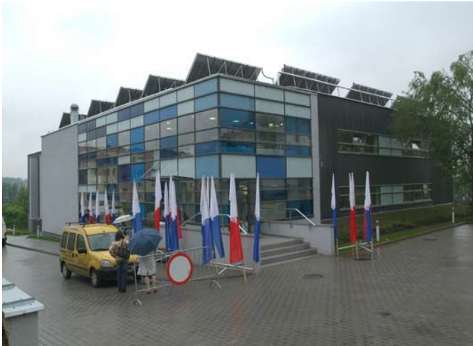
Budowa Ośrodka Rekreacyjno – Sportowego „Kurdwanów Nowy” w Krakowie
